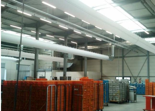
Conçue pour atteindre une diffusion de l'air optimale, la gaine perforée SIONAIR est la bonne réponse aux nombreuses exigences de confort des bâtiments industriels, commerciaux et tertiaires. Par l'utilisation du principe physique de la haute Induction, la perforation laser et le savoir-faire de plus de 25 ans de SIONAIR dans la diffusion d'air, permet d'atteindre la vitesse résiduelle optimale dans la zone d'occupation, en accord avec la norme **UNI 10339 EN 13182**
